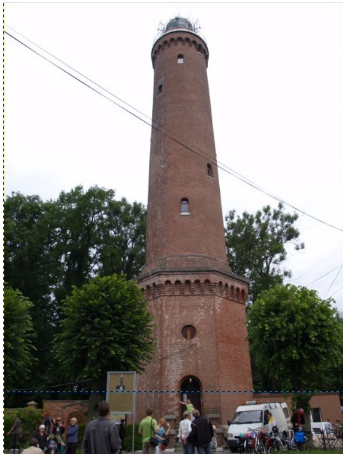
Przed obrotem bazą będzie poziomy murek
